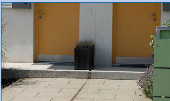
Abb. 18 Aufkantung am Gebäudezugang
