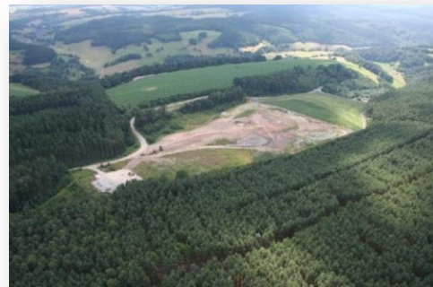
Abb. 15: Deponie Erdmannsdorf (Quelle: ZRO)
