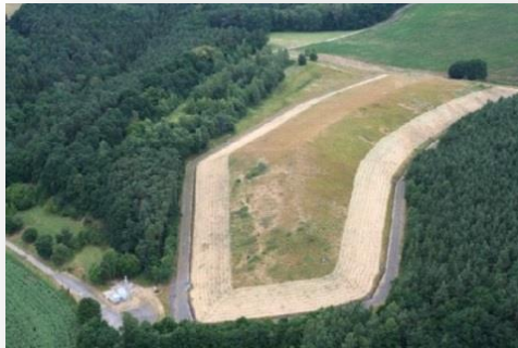
Abb. 14: Deponie Großbeutersdorf (Quelle: ZRO)
