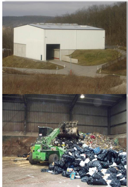
Abb. 12: Umladestation Großlöbichau (Quelle: ZRO)
