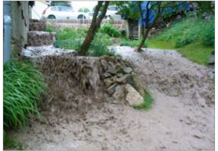
Abb. 17: Erhöhter Oberflächenabfluss mit Erosionsfolge nach einem Starkregenereignis in Kunitz
